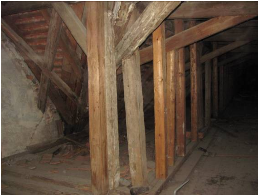
severo-západní roh – původní krov s dodatečným podepřením, uhnílá nárožní krokev
