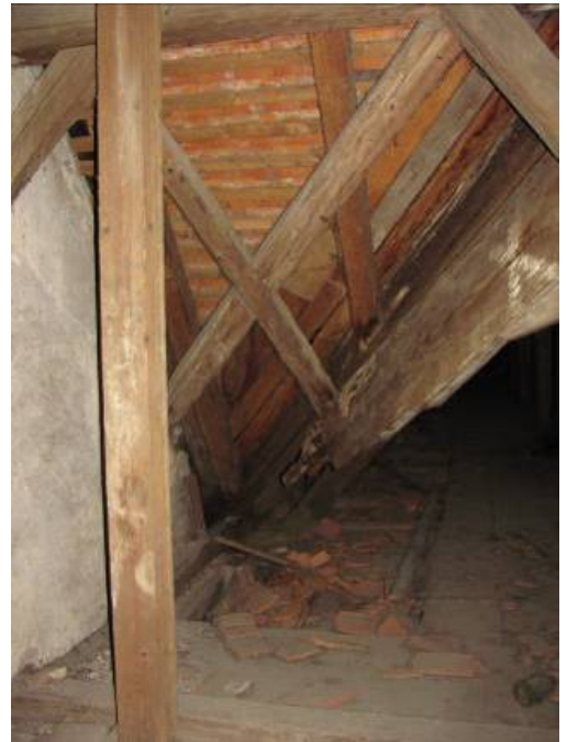
severo-západní roh – původní krov s dodatečným podepřením, uhnílá nárožní krokev
