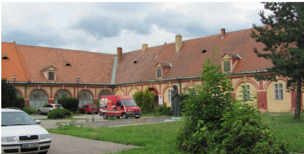
Stávající stav - pohled z jihu
