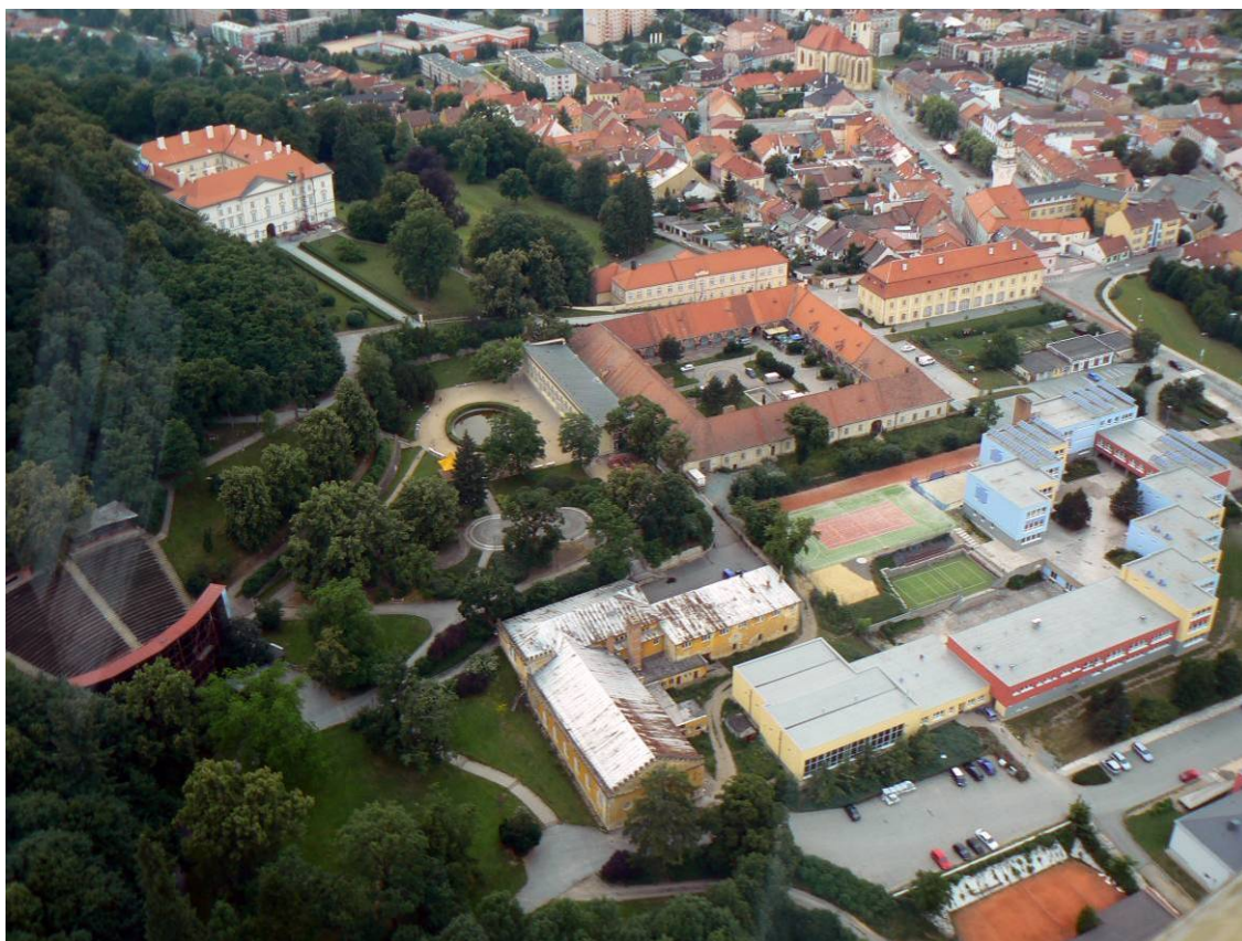
Sávající stav – letecký pohled z východu
