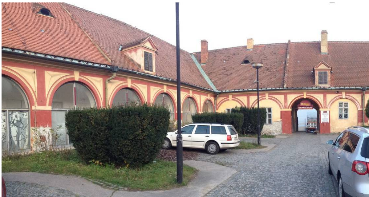
Sávající stav – pohled ze západu
